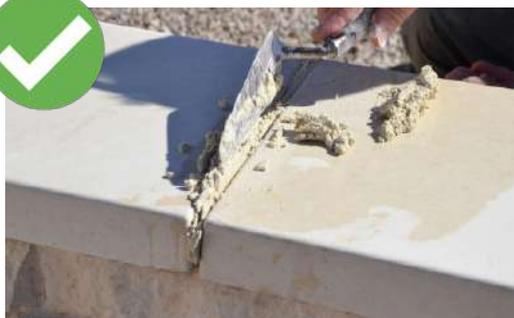
Réaliser le joint après séchage de la colle.
