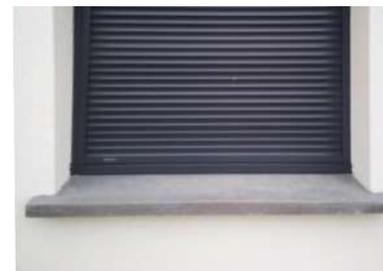
Rappel : Pour la pose des appuis de fenêtre ou seuils il est impératif de respecter une pente de 10%.
