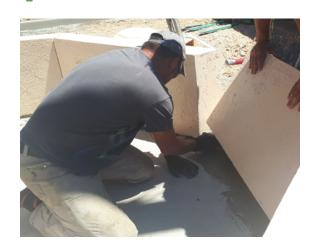
Coller «en plein» les éléments du bassin de la fontaine sur le radier. Utiliser la colle <u>662 Lankocem</u> pour coller les éléments au radier ainsi que les éléments entre eux.
