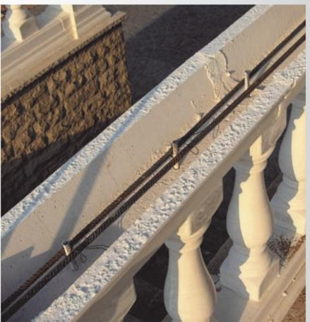
6. Une fois le socle supérieur posé et collé, le percer sur la partie interne ainsi que chaque balustre pour y sceller (Clavex ou similaire), un tors de  $\varnothing 6$ , longueur 15 cm.
