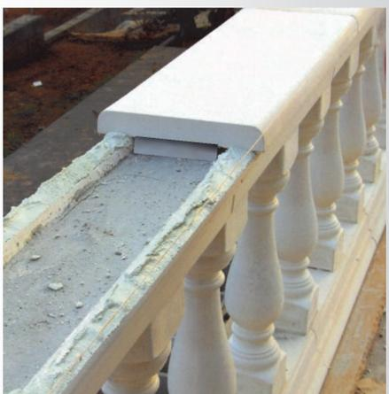
7. Après s'être assuré de la bonne étanchéité des socles supérieurs ainsi que celle des poteaux, les remplir de béton dosé à  $350 \text{ kg} / \text{m}^3$  ; araser proprement.
