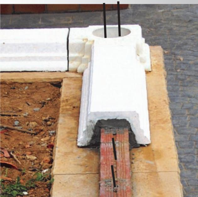
2. Ensuite, encastrer le socle en garnissant de mortier l'espace à combler entre la brique et le socle. Coller les socles les uns aux autres avec de la colle à carrelage blanche extérieure. Bien nettoyer les surplus de colle afin de parfaire le joint.
