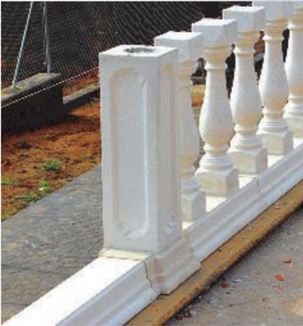
4. Poser les balustres sur le socle (4 au ml pour les décoratives ; 5 au ml pour les sécurités) en les collant à la colle à carrelage blanche extérieure.
