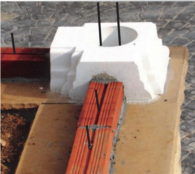
1. Sur le tracé à suivre, percer et sceller à l'aide de mortier de scellement hydraulique (type Clavex ou équivalent) des tors  $\varnothing 6$ , longueur totale 15 cm tous les 50 cm ainsi que 2 tors de  $\varnothing 6$ , longueur totale 40 cm au droit des poteaux afin de liasonner les armatures verticales ; puis, maçonner une file de briques ou similaire.
