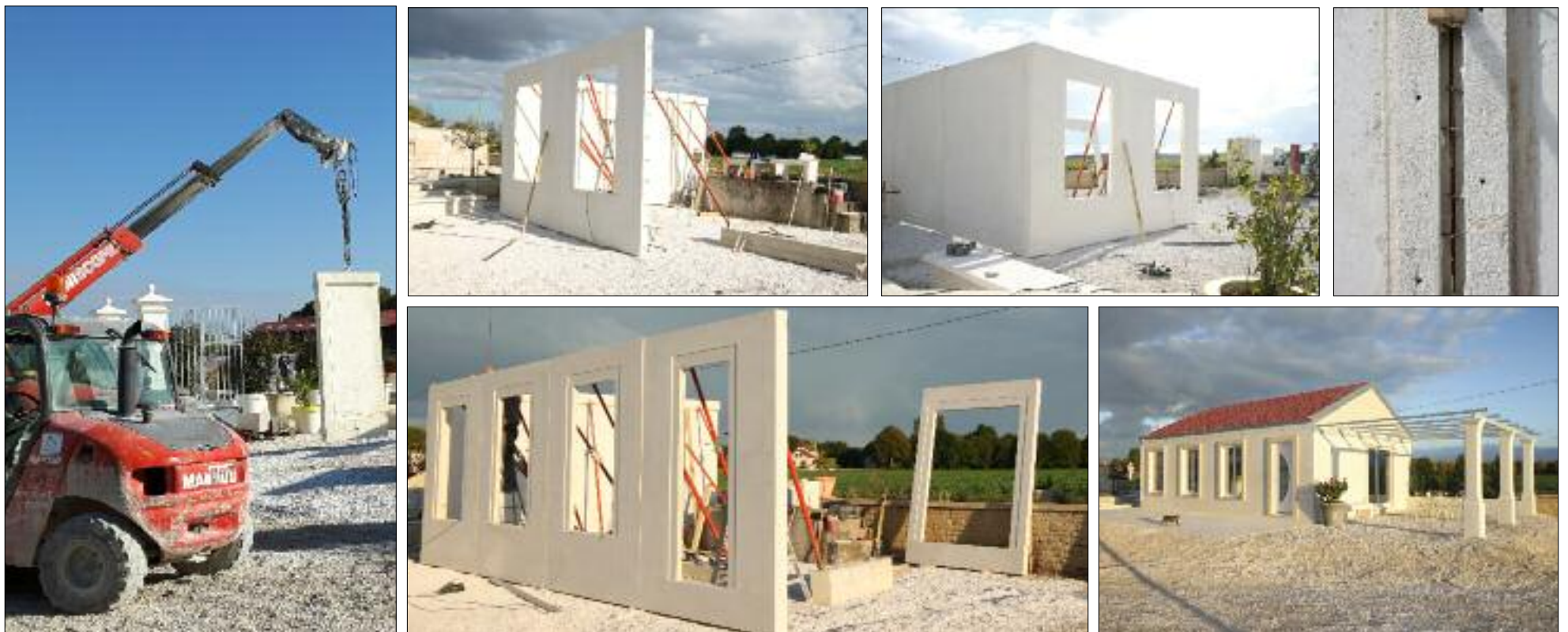
Composées de panneaux modulables en béton armé et décoratif, les « Maisons Éco » de la société Alentour offrent une rapidité de montage inégalée. Elle se veut à la fois économiques, écologiques et durables.
