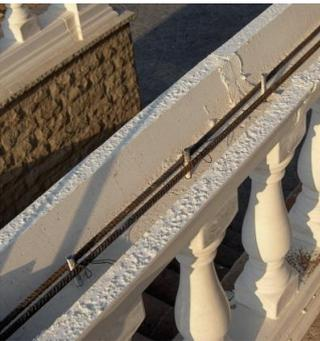
5. Une fois le socle supérieur posé et collé, le percer sur la partie interne ainsi que chaque balustre pour y sceller (Clavex ou similaire), un tors de  $\varnothing$  6, longueur 15 cm. Faire de même aux extrémités sur les socles des poteaux.
