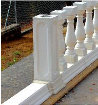
3. Poser les balustres sur le socle (4 au ml pour les décoratives ; 5 au ml pour les sécurités) en les collant à la colle à carrelage blanche extérieure.
