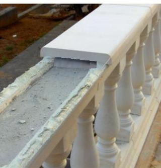
6. Après s'être assuré de la bonne étanchéité des socles supérieurs ainsi que celle des poteaux, les remplir de béton dosé à 350 kg / m<sup>3</sup> ; araser proprement.
