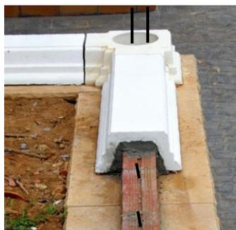
2. Ensuite, encastrer le socle en garnissant de mortier l'espace à combler entre la brique et le socle.
